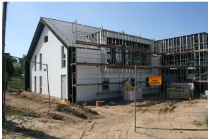
Stopień zaawansowania prac w czerwcu
