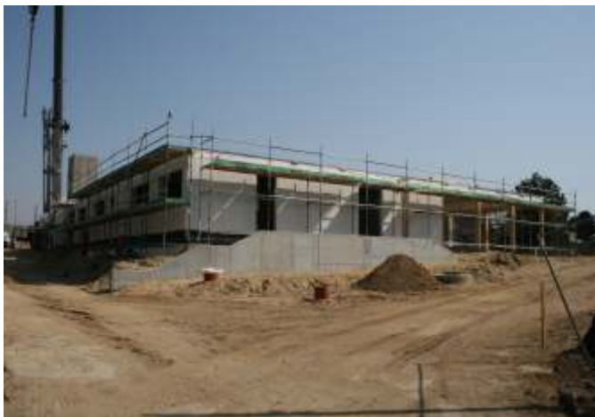
Stan budowy w kwietniu
