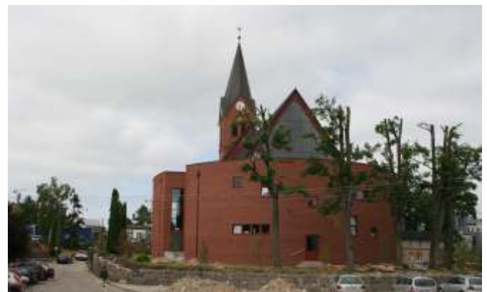
Obecnie trwają prace naprawcze przy kamiennej części ogrodzenia
