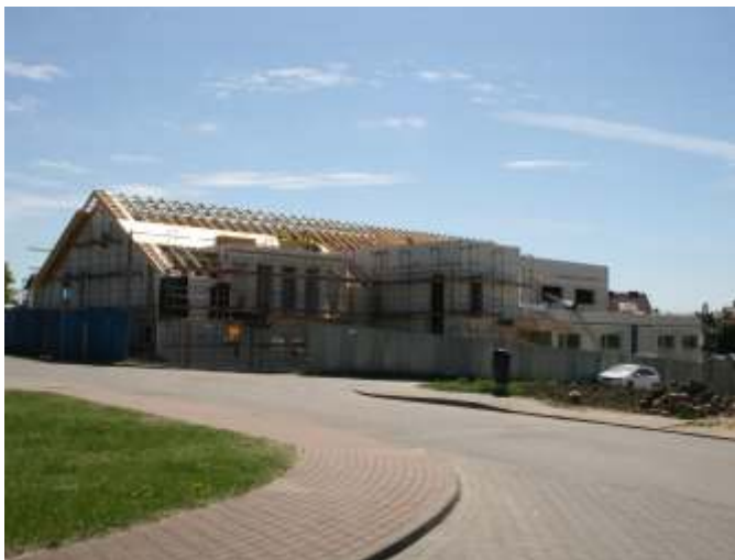
W maju pracownicy położyli dach
